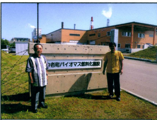
北海道白老町バイオマスごみ処理施設
